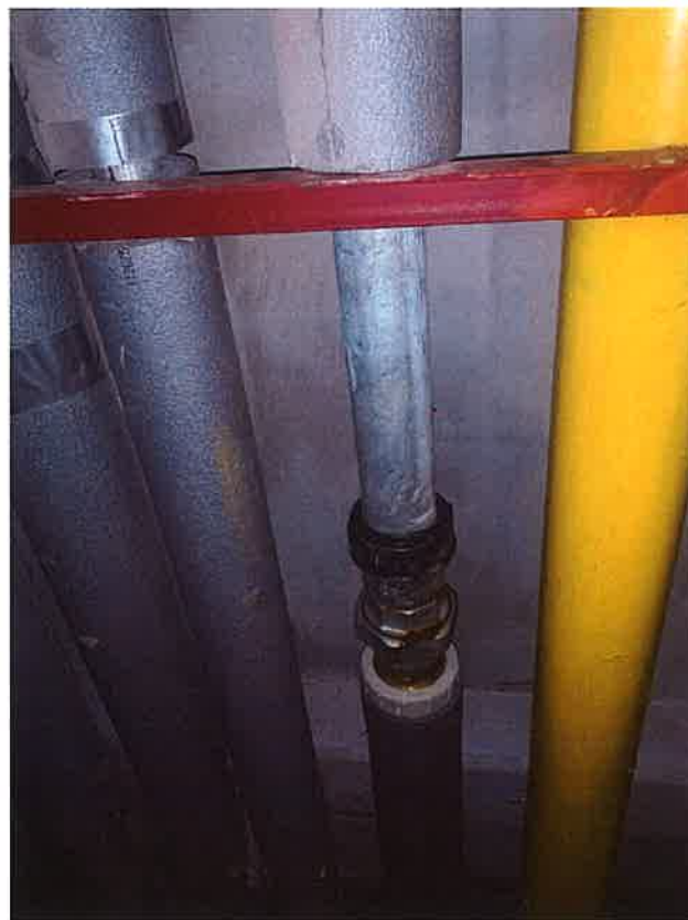
Zdjęcie nr 11- Naprawa tymczasowa instalacji za pomocą kształtki serwisowej GEBO
